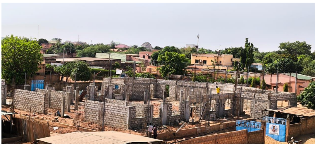
La Paroisse Saint Charles Lwanga de Wayalghin en chantier
