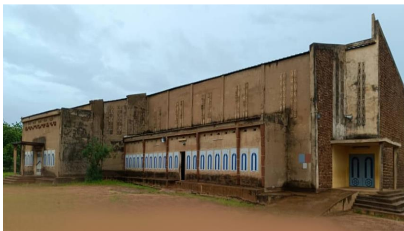
EGLISE AVANT RENOVATION
