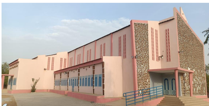
EGLISE APRES RENOVATION
